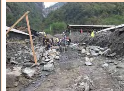
2011 年 4 月(溴水溝排導槽)
