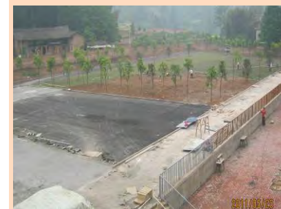
運動場(施工中)
