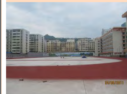
運動場(施工中)
