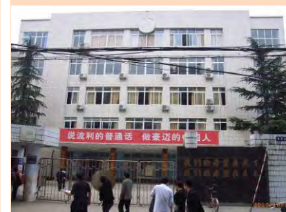
維修加固舊教學樓
