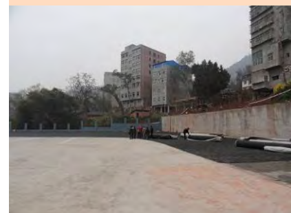
運動場(施工中)
