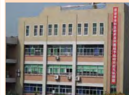
維修加固舊教學樓
