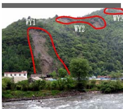
趙國紅酒廠後山 不穩定斜坡
