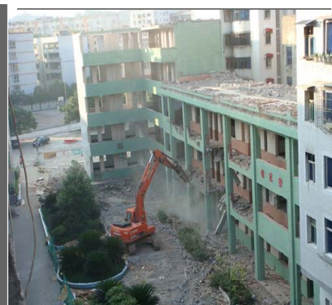
拆掉破損校舍
