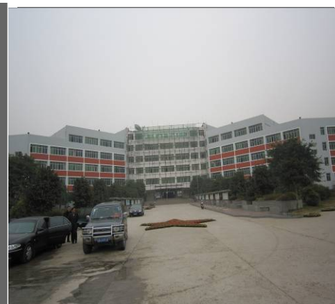
教學樓維修加固工程已完成
